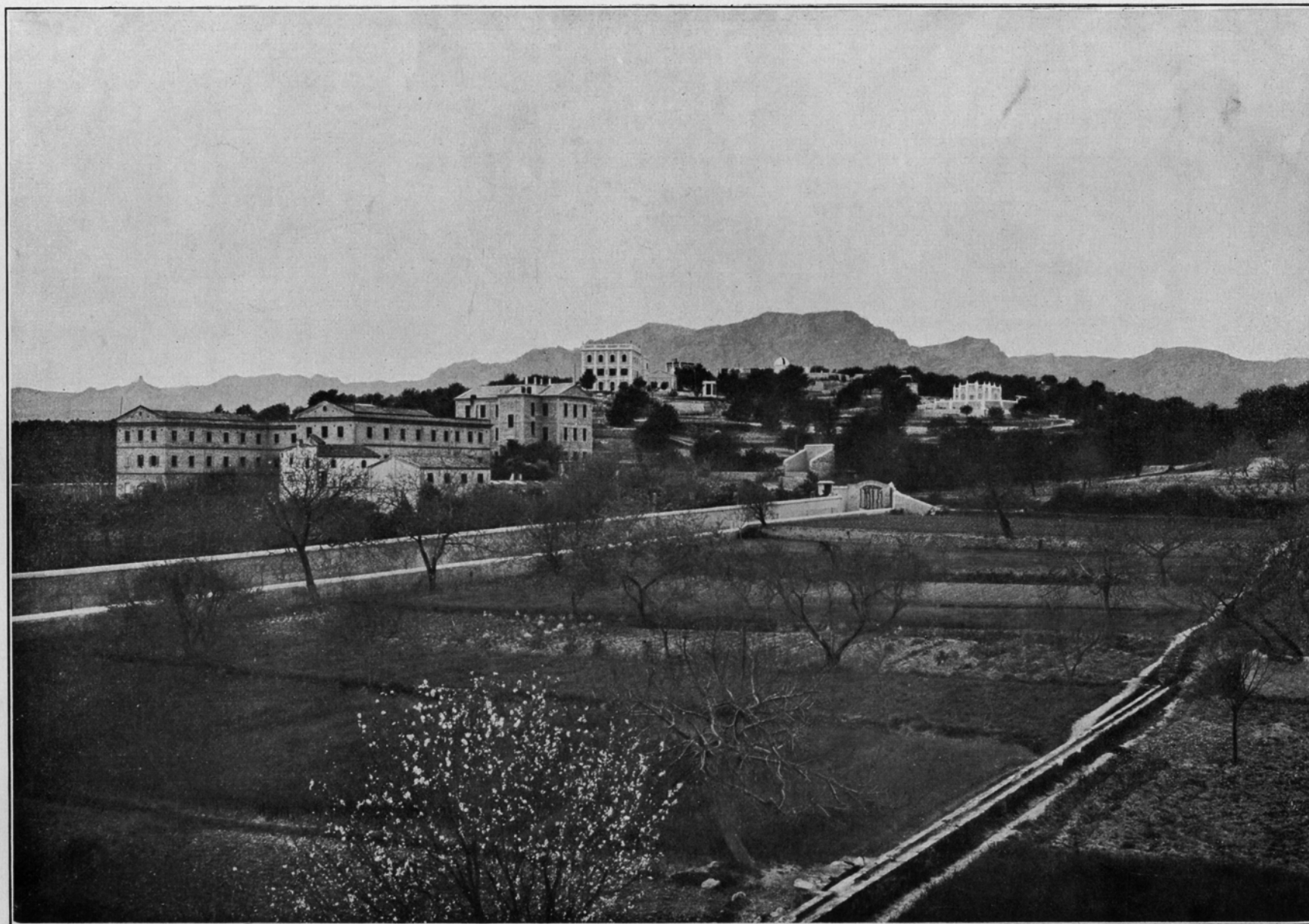
Lám. I. — Vista general del Colegio y del Observatorio
